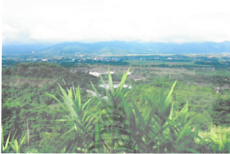
ภาพที่ 4-20 การครอบคลุมพื้นที่ติดตั้งอุปกรณ์ตรวจจับสภาพและเตือนภัยดินถล่ม
