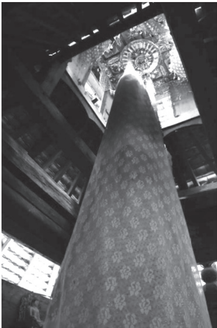
เจดีย์วัดบ้านแก่ง (บ้านแยก) ที่ถูกสร้างอาคารครอบอีกชั้นหนึ่ง
