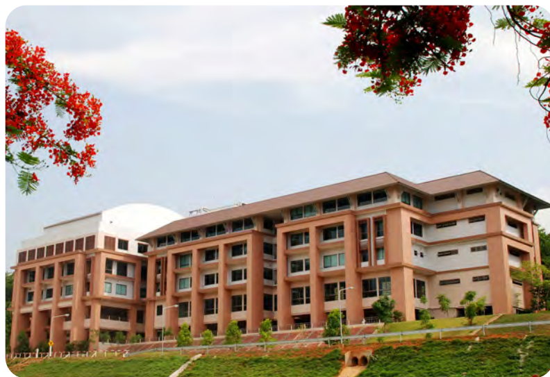
อาคารปริคลินิก M3
